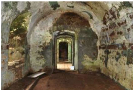
Figura 10: Vista interna da abóbada do Corpo da Guarda Fonte: Acervo dos autores, 2020
