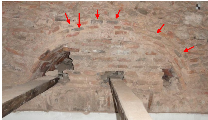
Figura 4: Arco de descarga da Igreja de São Pedro dos Clérigos, com indicação do uso de tijolos mais queimados. Fonte: SANTOS, 2012.
