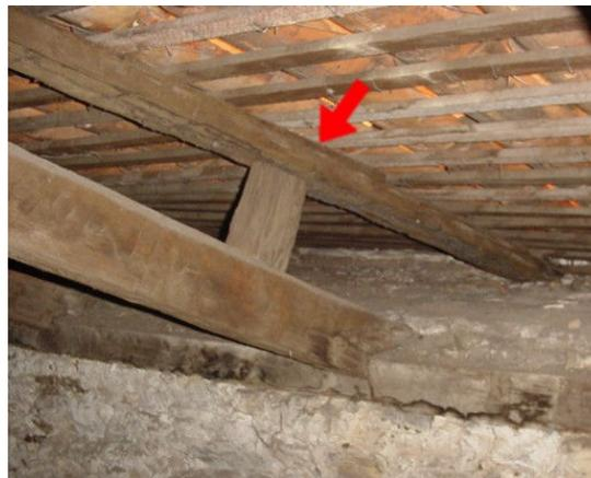
Figura 4 – Detalhe do apoio e contra-caibro assentado com a maior dimensão no sentido horizontal (Fonte: 2ª SR/IPHAN)
