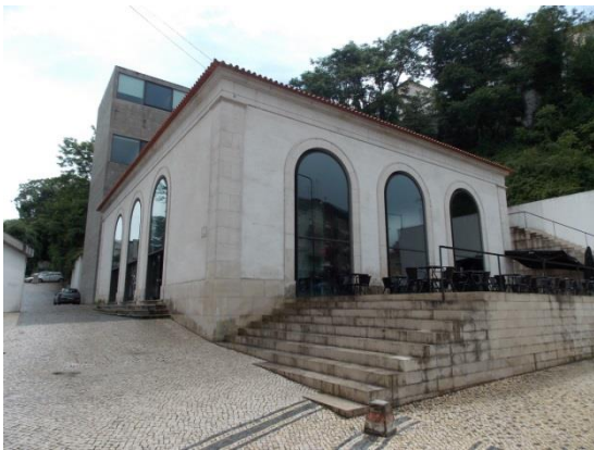
Imagen 01 – Vista externa general de la antigua Casa de las Calderas de los Hospitales de la Universidad de Coimbra (Foto: Nivaldo Andrade, mayo/2014)
