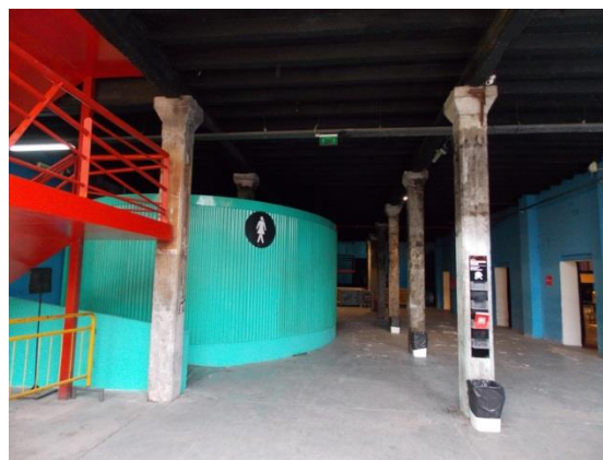
Imagen 04 – Vista general del nuevo volumen de los baños (verde) y de la escalera (roja) insertados en la planta baja de uno de los antiguos pabellones de la Ciudad Cultural Konex (Foto: Nivaldo Andrade, abril/2015)
